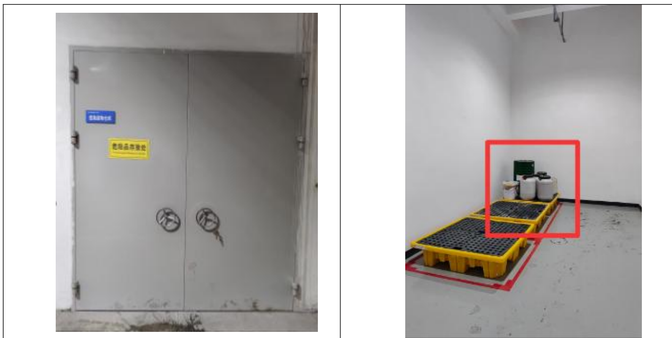
图3-2 危废暂存间图片
